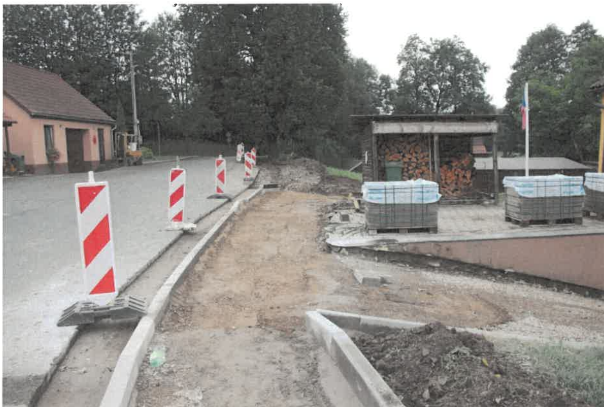
Obrázek 6: Probíhající práce na projektu obce Radkovice u Budče - Novostavba chodníku II – 3. Výzva IROP Doprava
