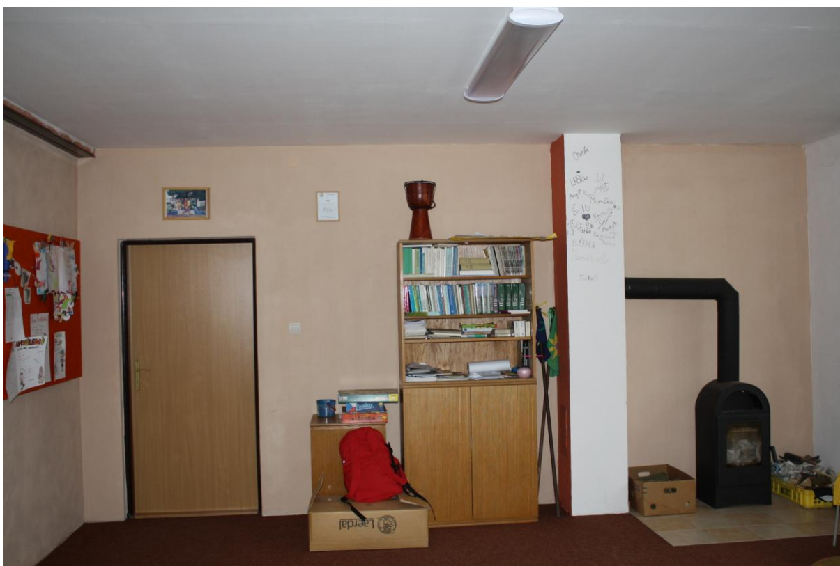
Obrázek 1: Přístavba víceúčelových kluboven – Junák – kontrola SZIF březen 2014
