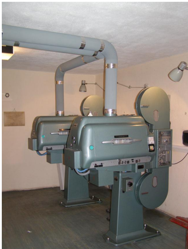
Obrázek 4:: Fyzická kontrola projektu - Rekonstrukce promítacího zařízení areálu letního kina
